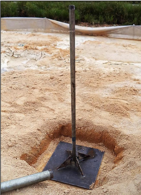
Contoh settlement plate marker yang perlu dipasang bagi menyukat dan memantau pemendapan.
