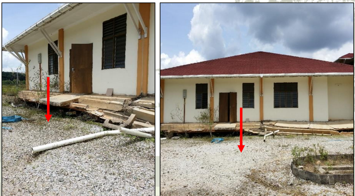
Kejadian pemendapan pembinaan di atas lapisan tanah gambut
