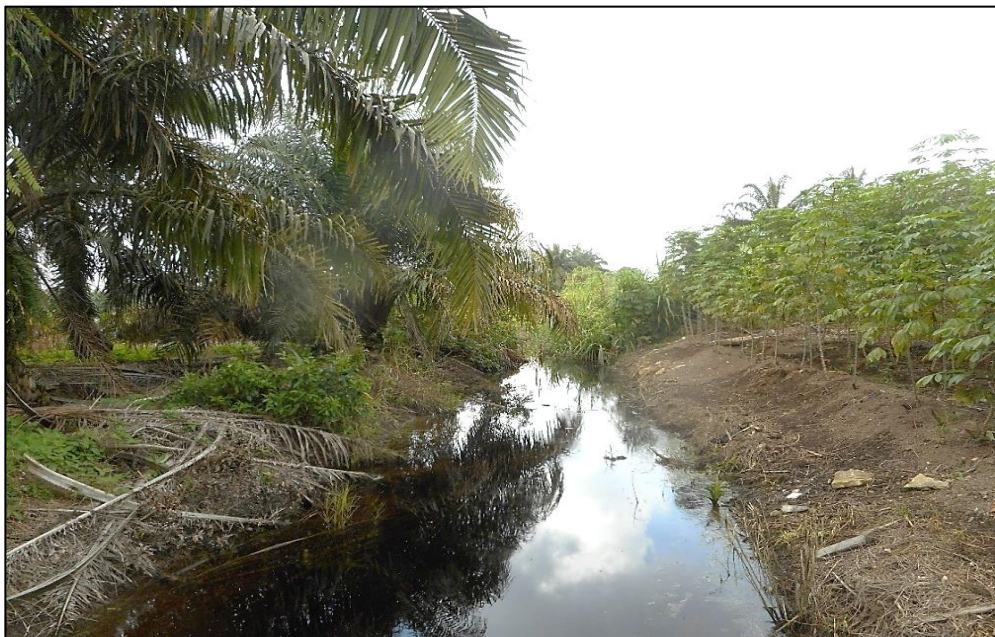
Sistem pengairan seperti double drainage merupakan sistem mitigasi banjir terbaik sebagai penstabil paras air di kawasan tanah gambut.
